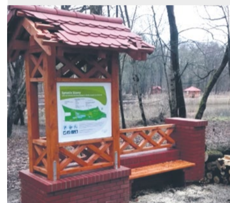
Uszkodzona bramka przy wejściu na teren Syrenich Stawów.
