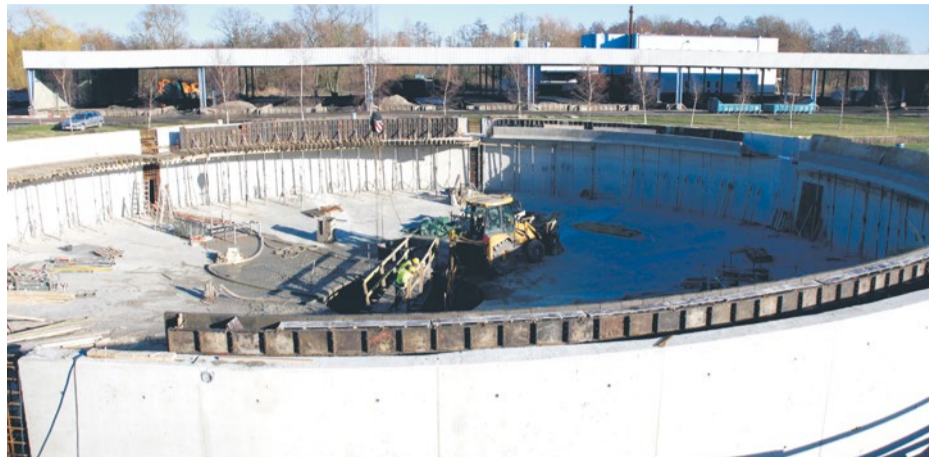
Budowa osadnika wtórnego.
