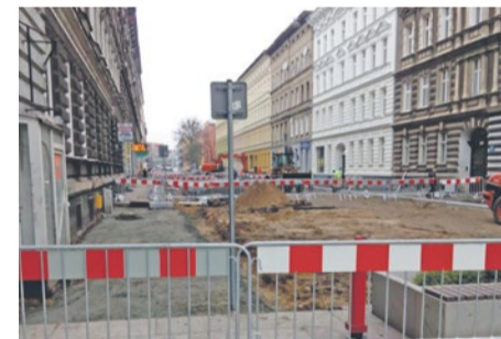
Przebudowa ul. Małkowskiego
