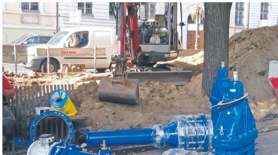
Montaż jednego z punktów pomiarowych
