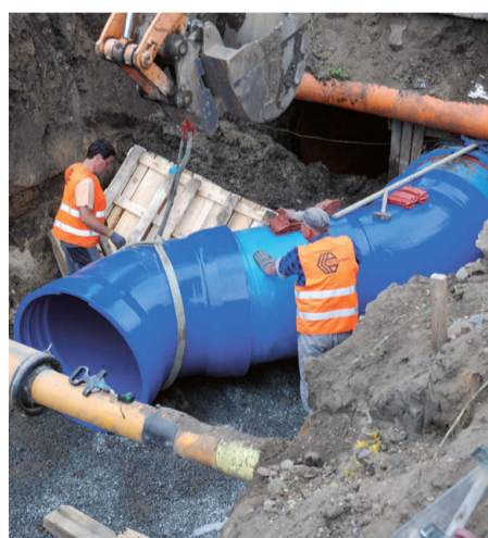
Układanie nowego rurociągu
