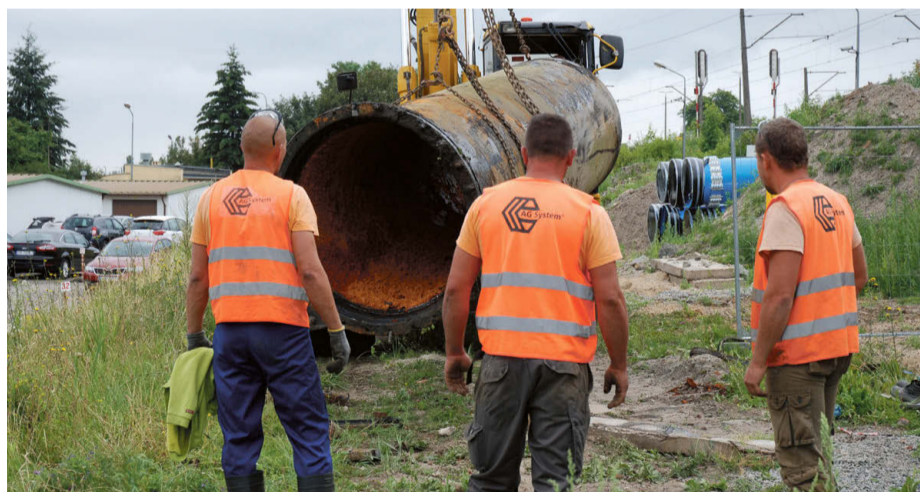
Demontaż starej „miedwianki”
