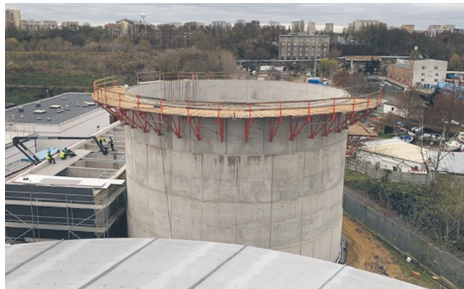
Budowa nowej, wydzielonej komory fermentacji w oczyszczalni „Pomorzań”
