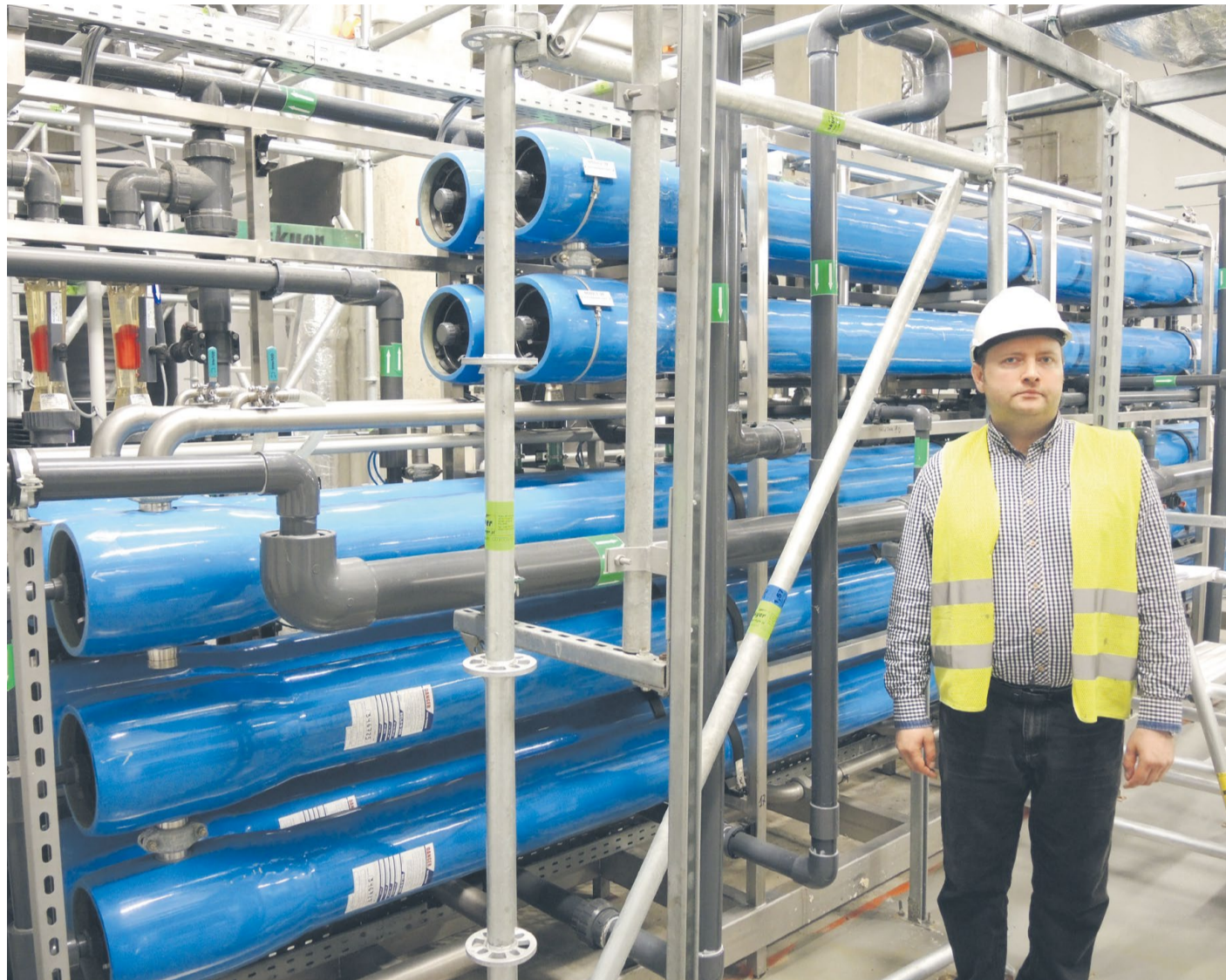
W EcoGeneratorze nadzór nad pracą instalacji do odwróconej osmozy sprawuje Michał Kaliś, specjalista ds. urządzeń pozablokowych
