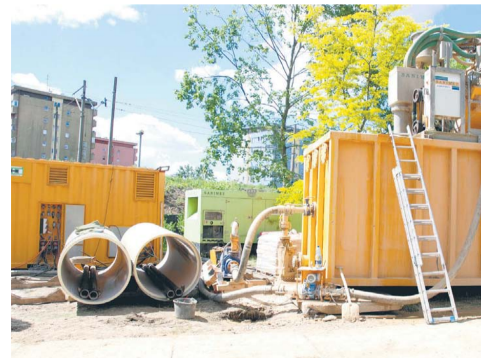
Początkowy etap budowy nowego kolektora
