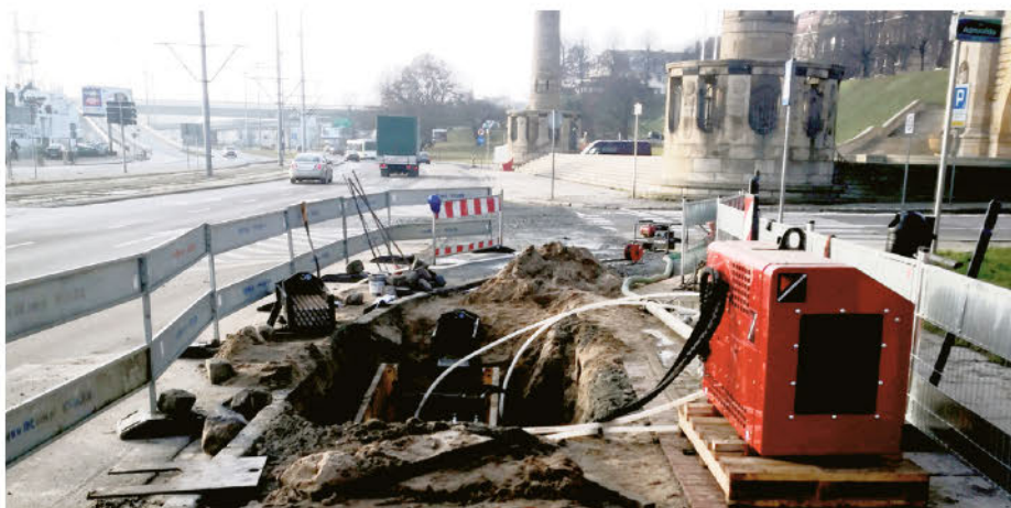
Prace na ul. Jana z Kolna
