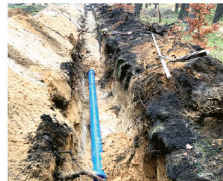
Wodociąg do Załomia w trakcie budowy
