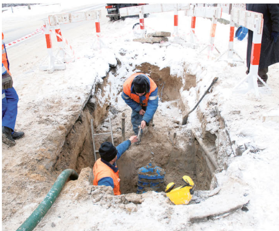
Naprawa awarii wodociągu jest zimą o wiele trudniejsza.
