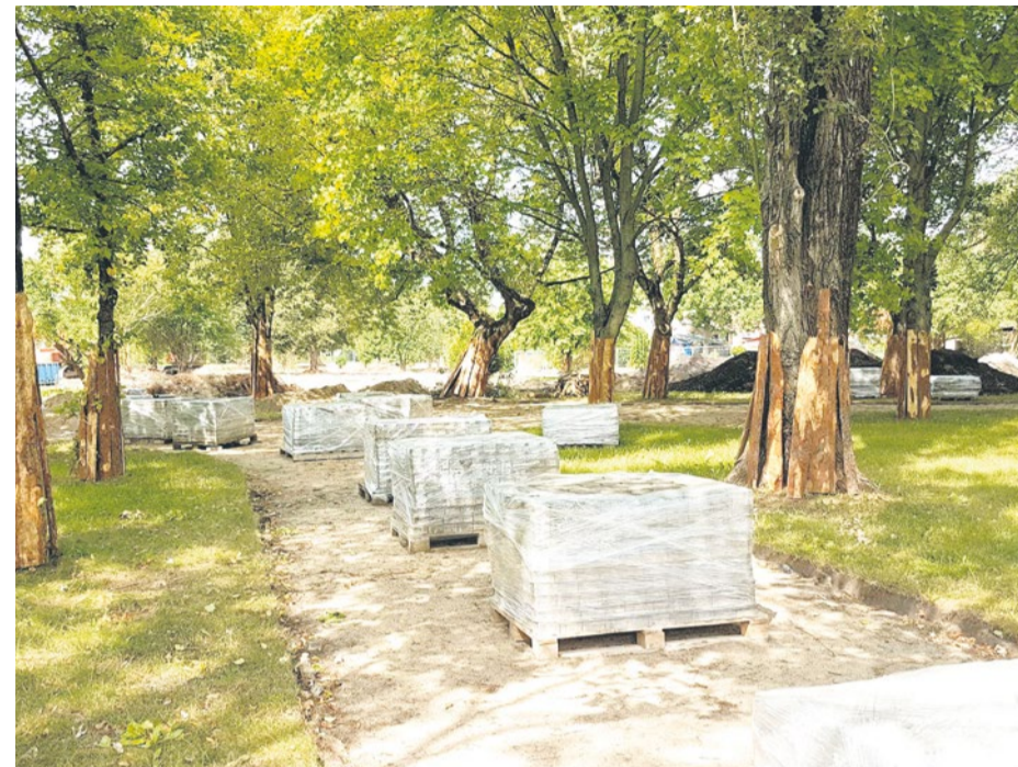
Przygotowania do modernizacji alejek
