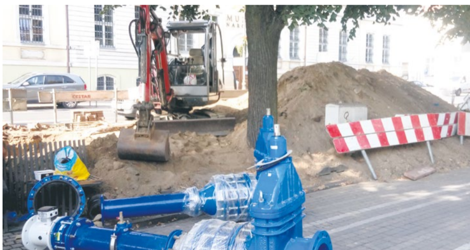
Montaż przepływomierza wody na pl. Żołnierza
