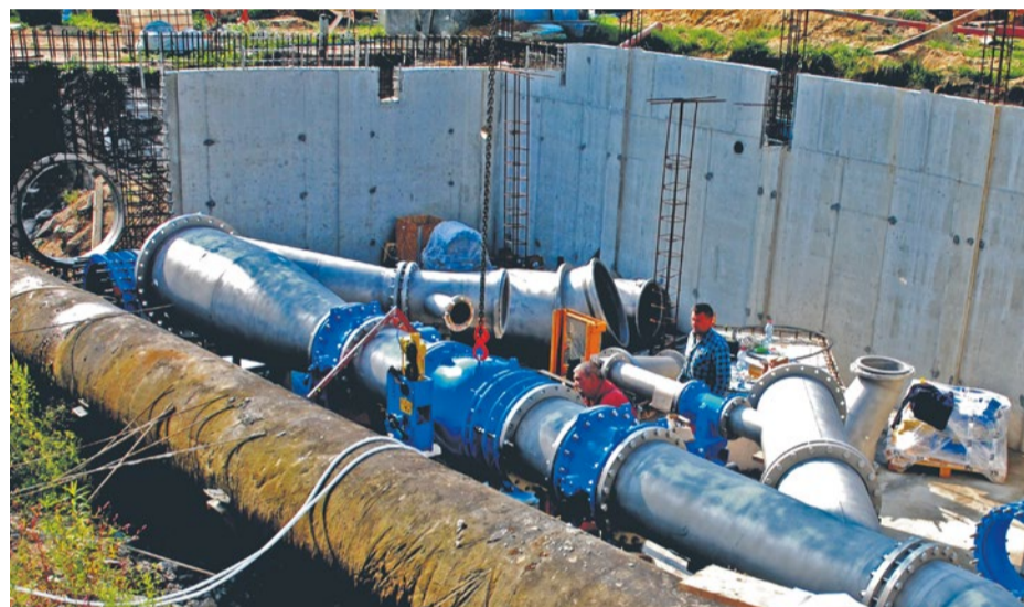
Montaż rurociągu pod turbinę w Zakładzie Produkcji Wody „Pomorzany”
