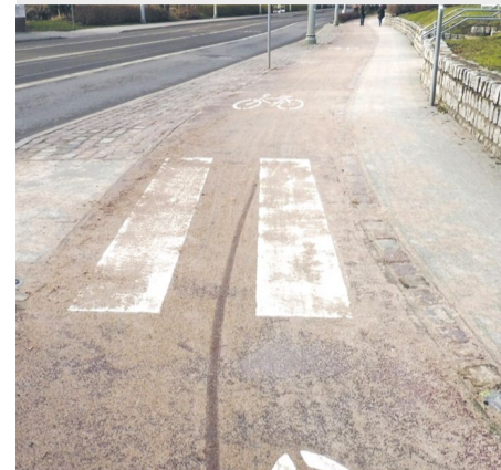
Rozsypany piasek na ścieżce rowerowej i chodniku przy ul. Arkońskiej między ul. Harcerzy i Wojciechowskiego
