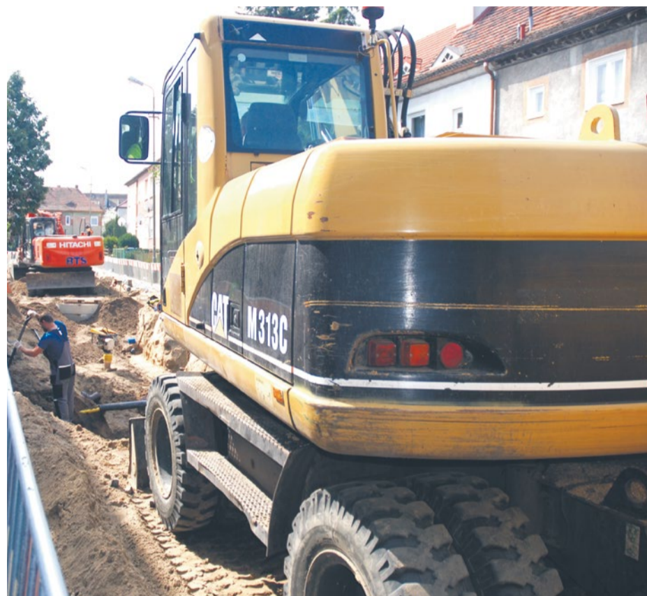
Prace na ul. Libelta
