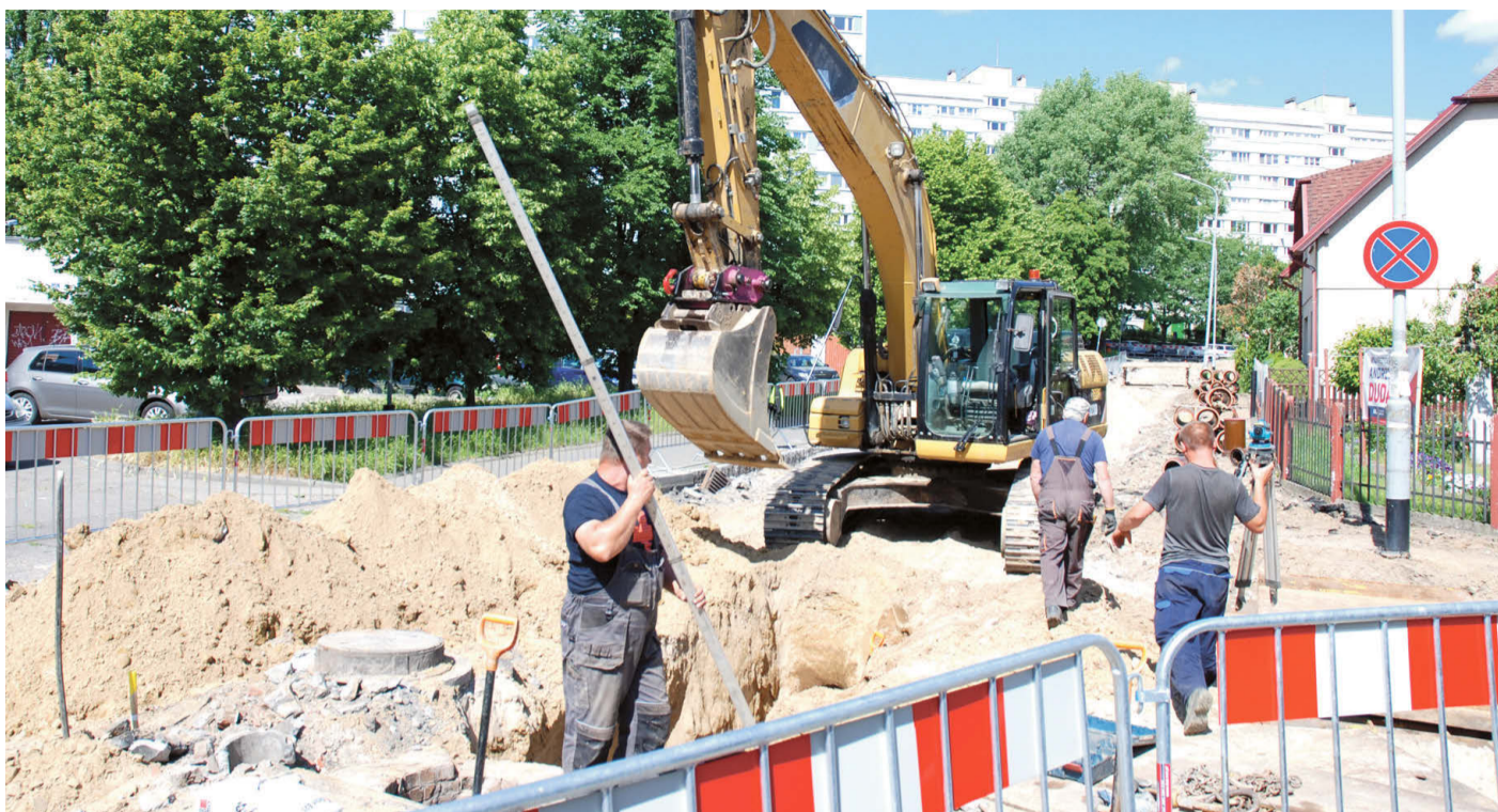
Na skrzyżowaniu ulic Jodłowej i Kłosowej trwają intensywne prace ziemne.
