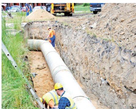
Ostatni etap układania kolektora deszczowego w Parku Brodowskim
