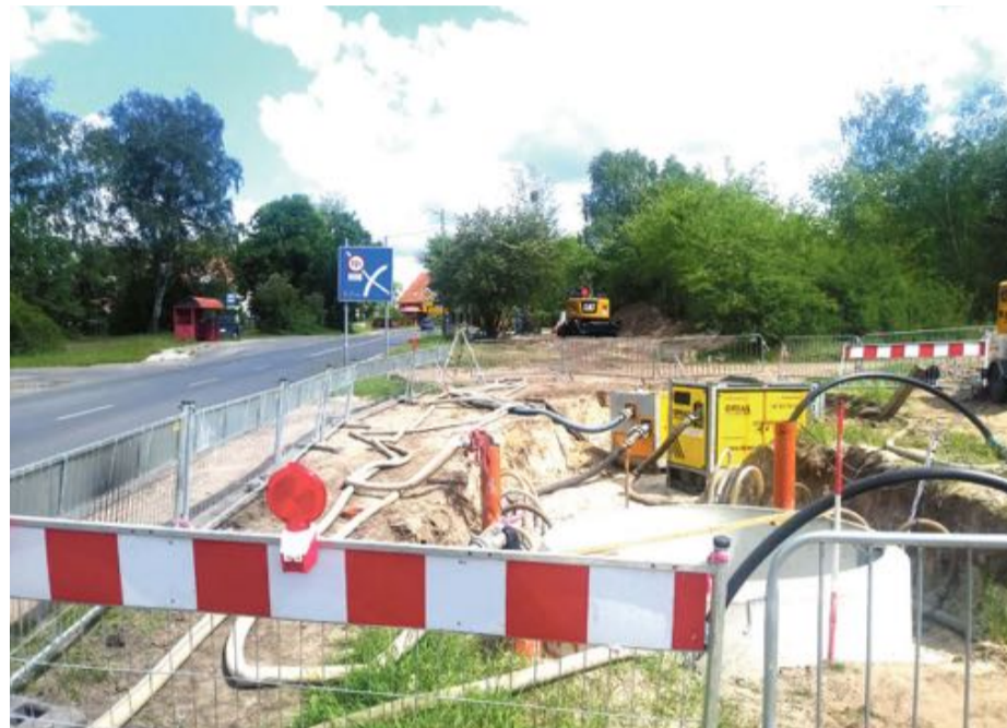
Inwestycja jest kontynuowana. Na zdjęciu prace na ul. Tczewskiej.
