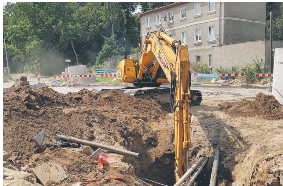
Przebudowa skrzyżowania jest już mocno zaawansowana
