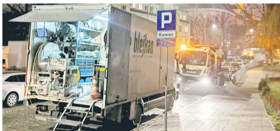
Większość prac prowadzono nocą, żeby zminimalizować utrudnienia dla mieszkańców.
